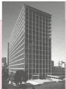
「鹿島赤坂別館」外観
