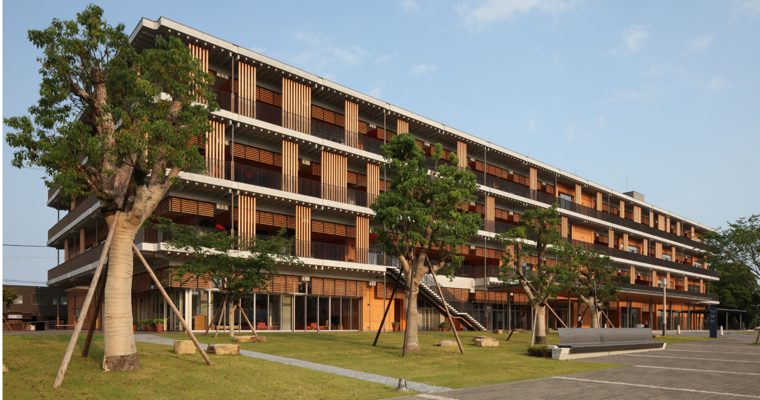
建物外周部に大きくテラスを張り出した半屋外空間
